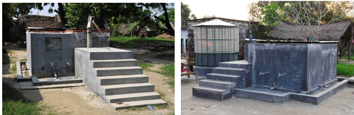
第 1 フェーズでは、8 つの小石・砂フィルター(左)と 3 つの掘り井戸フィルター(右)が設置されました(写真撮影: BAMP)
