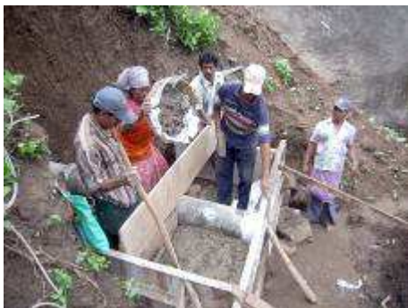
写真:ゴディヤパドゥ村における堰水建設(写真:ソムニード提供)
